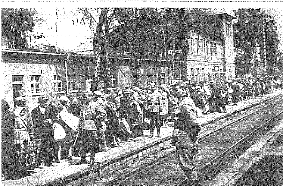
Dworzec kolejowy w Olkuszu (napis na budynku dworcowym "Ilkenau"). Oczekiwanie na pociąg, spojrzenia skierowane na zachód w stronę Bukowna. (Źródło: BLH, SWMLOC, ZIH)
