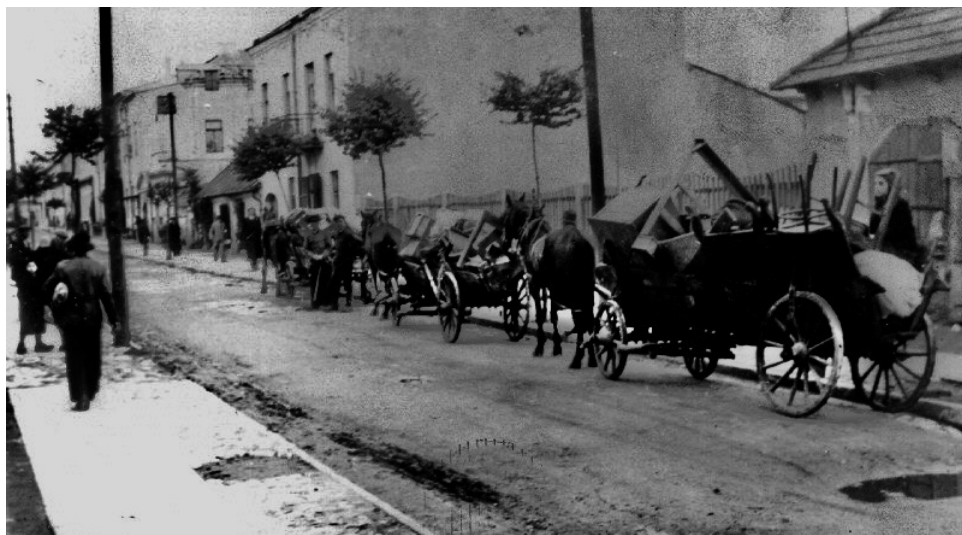
Szpitalna, wrzesień 1941 r., przesiedlenie Żydów do getta, od prawej parterowy Daszyńskiego/Szpitalna 26, piętrowy 28 i zabudowania szpitalne 30-34 (źródło: GFH oraz https://collections.ushmm.org/search/catalog/pa1064985 )
